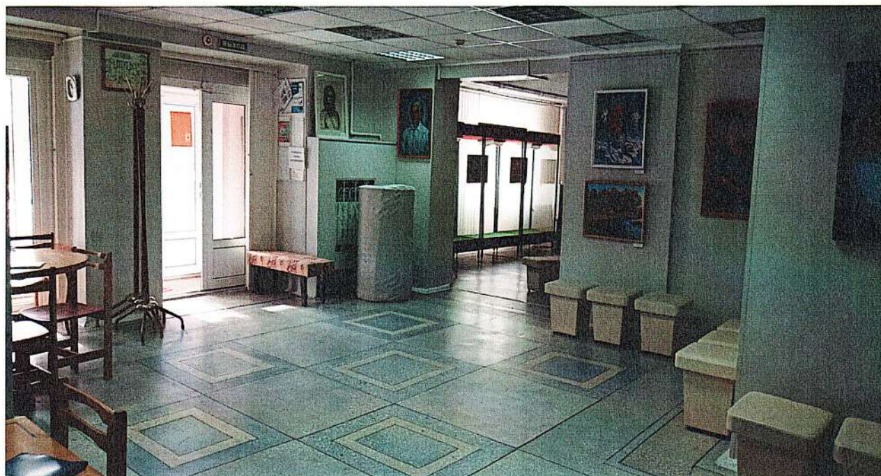
Отсутствует мнемосхема, что не соответствует требованиям п. 6.5.12 СП 59.13330.2020 Отсутствует контрастная маркировка открытого проема в стене, что не отвечает требованиям п. 6.4.1, п.6.2.23 СП 59.13330.2020
